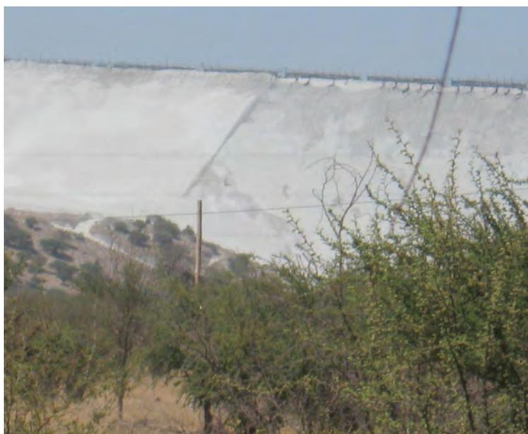
**Figura 3a.** Tranque de relaves Las Tórtolas de Minera Angloamerican, donde se observa fractura y hundimiento parcial de su muro de contención después del sismo de febrero de 2010.
